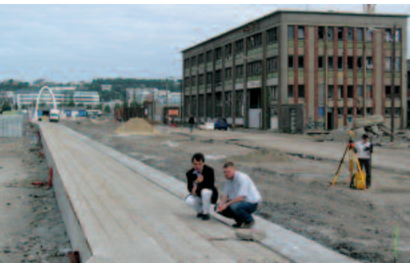
La future chaussée de la rue Bellot en cours de travaux. Au loin, le pont des Docks.
