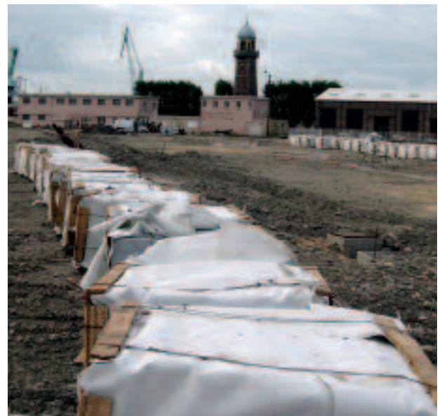
Ces bordures de granit, ici encore en colis, sont en cours de pose depuis le mois de mai, dans le prolongement de la rue Bellot, au départ du jardin fluvial.
