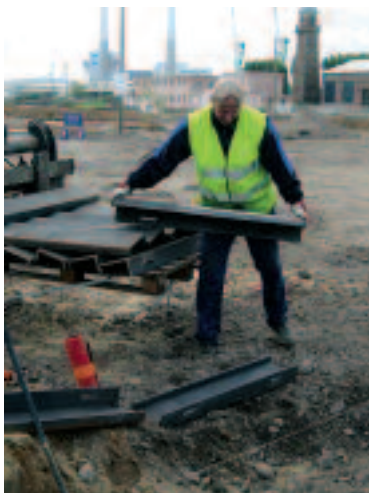
Les 10 km de rails en fonte spécialement conçus pour le site sont en cours de pose rue Bellot.
