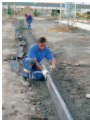
Les 10 km de rails en fonte spécialement conçus pour le site sont en cours de pose rue Bellot.
